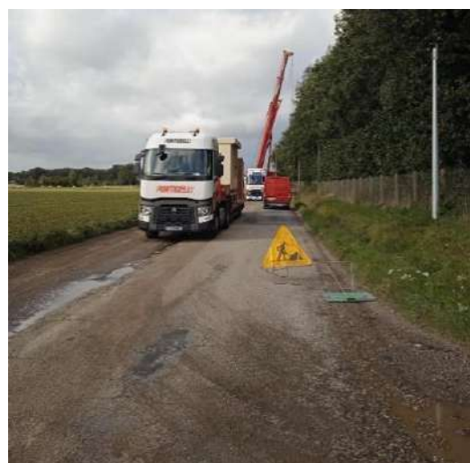
Livraison du poste EDF le 25 septembre 2024
