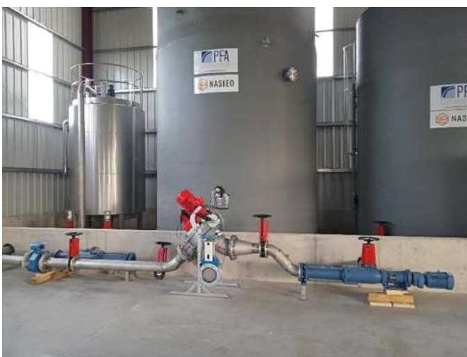
Mise en place du broyeur en août 2024
