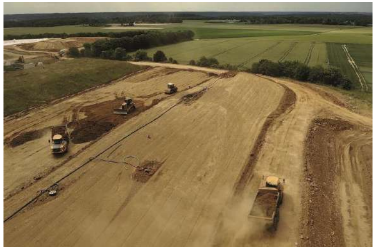
Emplacement du futur parc photovoltaïque, sur d'anciens casiers.
